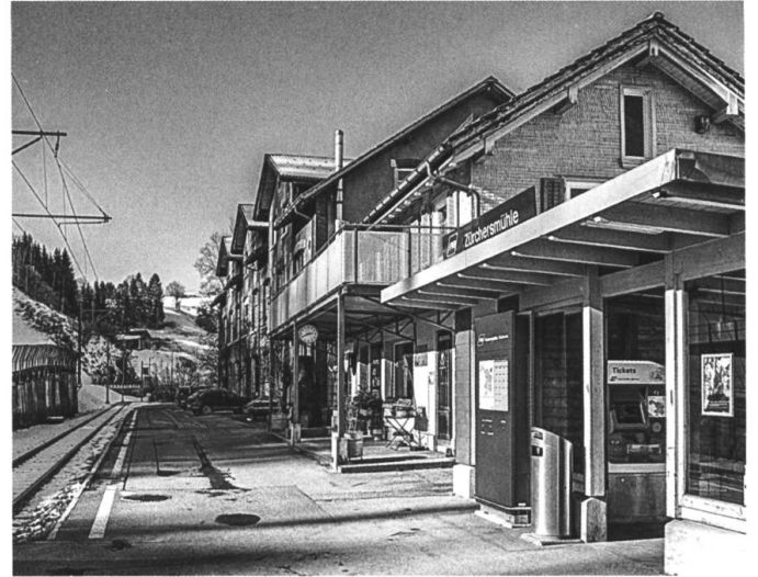
Auch der Bahnhof Zürichersmühle muss behindertengerecht ausgebaut werden.
