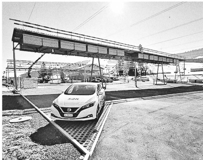
Der Parkplatz beim Kronberg hat seit Sommer 2020 ein Solarfaltdach.
