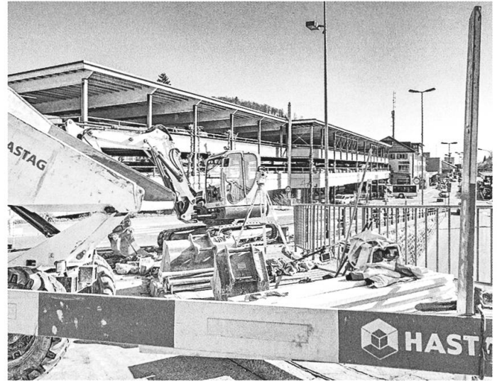
Am Bahnhof Herisau haben im April 2021 die Bauarbeiten begonnen.
