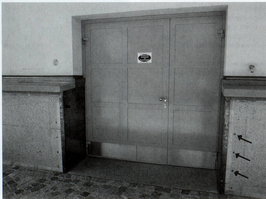
Dans des endroits où le risque existe, l'adoption de barrières anti-eau préparées à l'avance et à disposition près de la porte concernée, peut permettre d'annuler l'effet d'inondations provenant de l'extérieur, ou au moins d'augmenter le temps disponible pour l'évacuation des magasins. Ici les portes de l'Archivio di Stato à Bellinzona, avec les points de fixation des barrières anti-eau.
