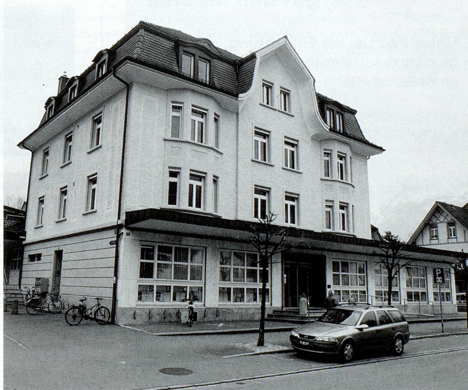
Altdorf, Bahnhofstrasse 13: Hauptsitz von Staatsarchiv und Kantonsbibliothek Uri.
