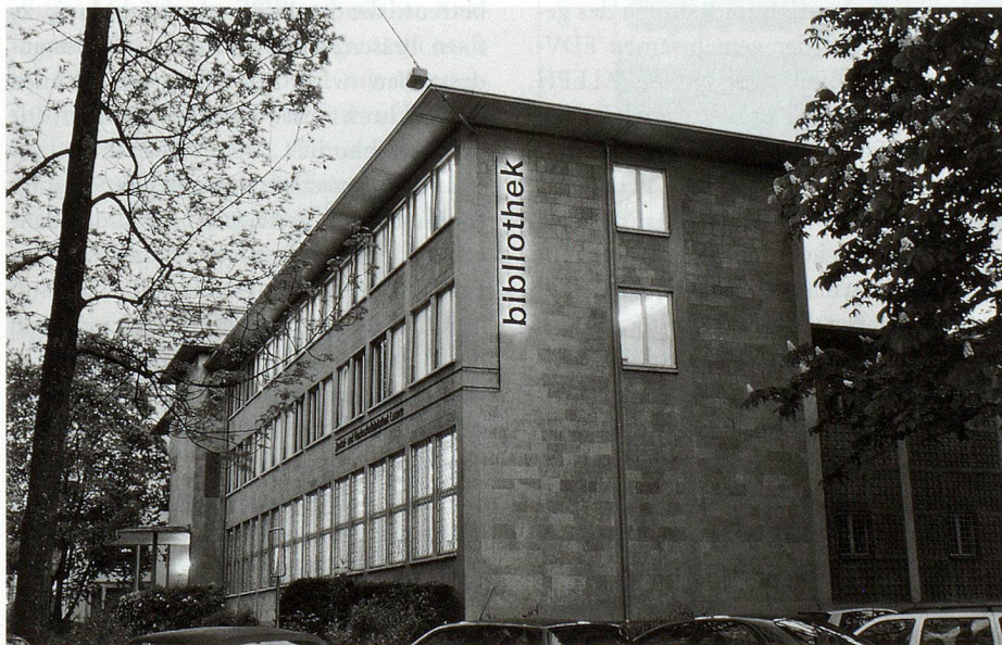
ZHB Luzern, Hauptgebäude, Sempacherstrasse 10.
