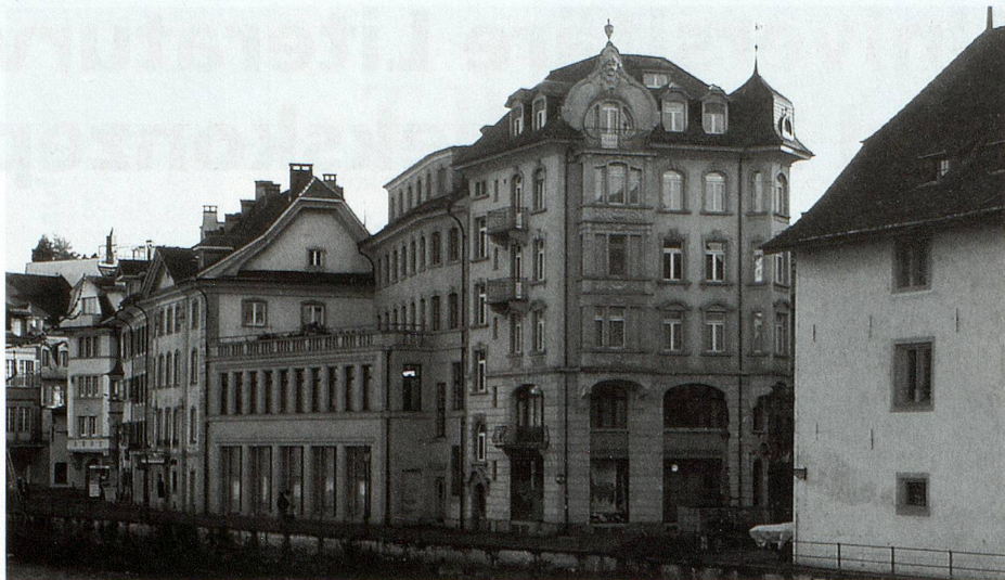
Universität Luzern, Hauptgebäude, Pfistergasse 20.
