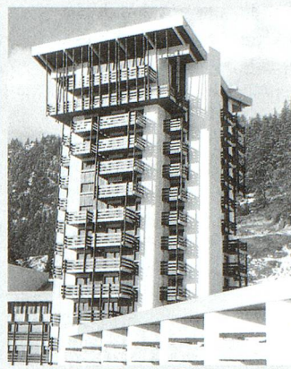
Tour d'Aminona (VS), André et Francis Gaillard, architectes, vers 1970–1971 (© Acm-EPFL).
