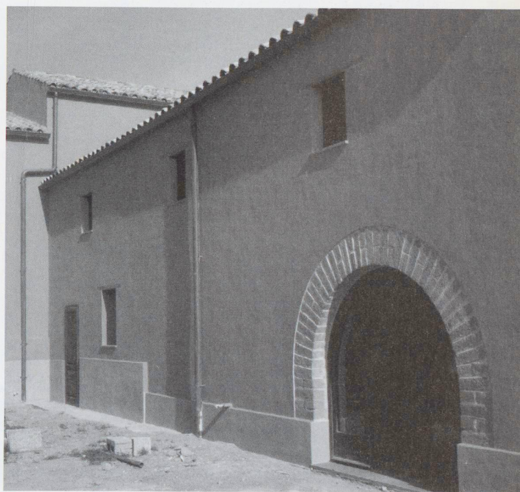
Biblioteca di Samassi, vista dell'ingresso sul lato della corte
