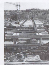
5 – Vista frontale dell'avanzamento Ponte-Passerella
