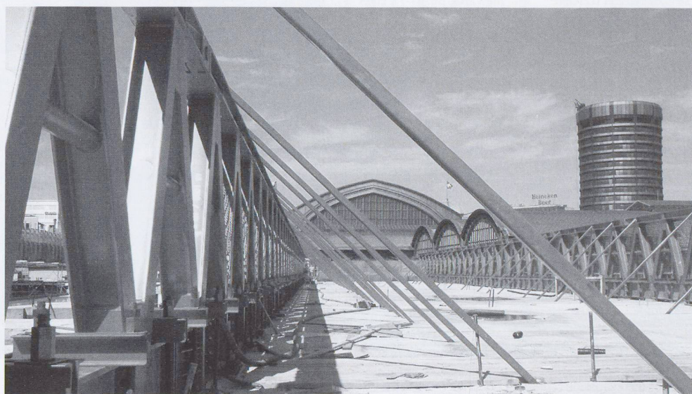
2 – Vista superiore del ponte a cassone con i due tralicci di acciaio di rinforzo temporanei
