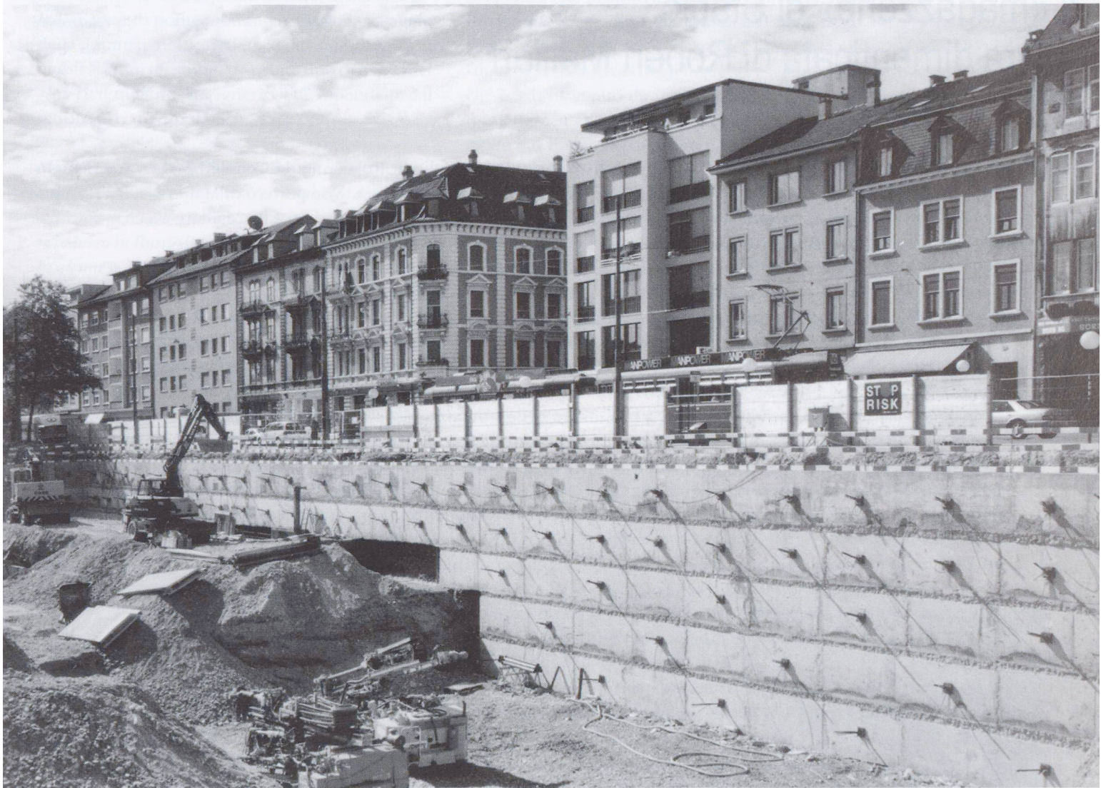
8 – Parete ancorata lungo la Güterstrasse
