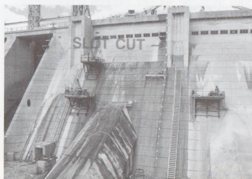
10 – Taglio realizzato mediante filo diamantato alla diga di Mactaquac (Canada)
