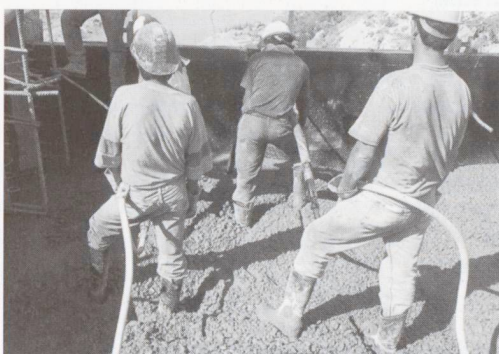
7 - Classica messa in opera di calcestruzzo vibrato
