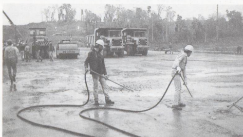
6 - Messa in opera del calcestruzzo rullato
