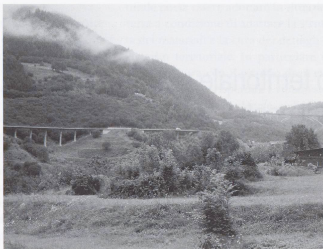
Strada del Passo del S. Bernardino con ponti a travata in costa e ad arco sulla valle (Nanin e Cascella), Mesocco-Pian San Giacomo, 1966-68, C. Menn
