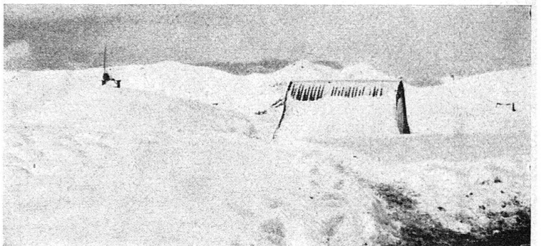
Bild 9: Auch ohne künstliche Hilfsmittel sind die Unterstände im Winter gegen Fliegereinsicht genügend getarnt. Bei starkem Schneefall sorgen Schneeverwehungen bzw. Schneeabrutsch für zusätzliche natürliche Tarnung.
