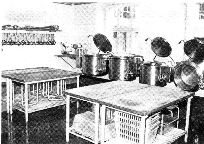
Neuzeitliche Elektroküche mit Kippkessel.
