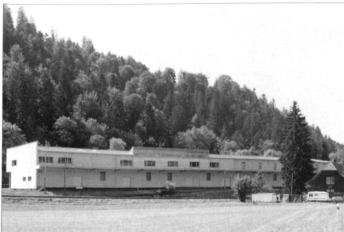
Ein Blick auf die Nordfassade der Ausbildungsanlagen Grünenmatt.
