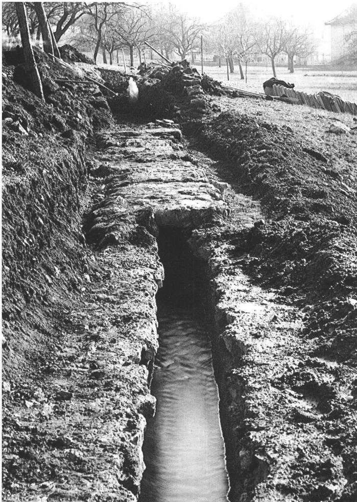
Abb. 12 Blick auf die 1934 geöffnete wasserführende römische Wasserleitung zwischen der Brunnenstube und Schacht »B«. Vue du segment de canalisation romaine ouverte en 1934 entre le réservoir et le regard »B«. Vista sul tratto del condotto d'acqua tra il serbatoio e il pozzetto »B« portato alla luce nel 1934.
