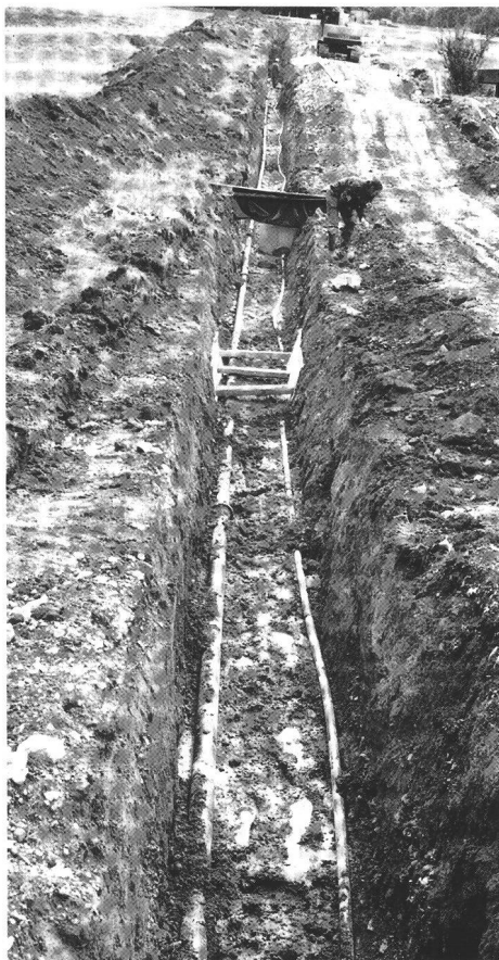
Abb. 3 Fläsch, Luzisteig-Answisen. Leitungsgraben von Norden; in der Bildmitte: Sprössung der Grabenwände bei der kohligen Grube. Foto AD GR. Fläsch, Luzisteig-Answisen. La tran- chée de la canalisation vue du nord. Au centre de l'image, l'étaillage des parois à proximité de la fosse char- bonneuse. Fläsch, Luzisteig-Answisen. Canalizzazione da nord; al centro: armatura delle pareti della fossa carboniosa.
