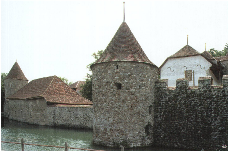
Abb. 12 Schloss Hallwyl. Nördlicher Geschützturm der Kernburg, erbaut um 1500.
