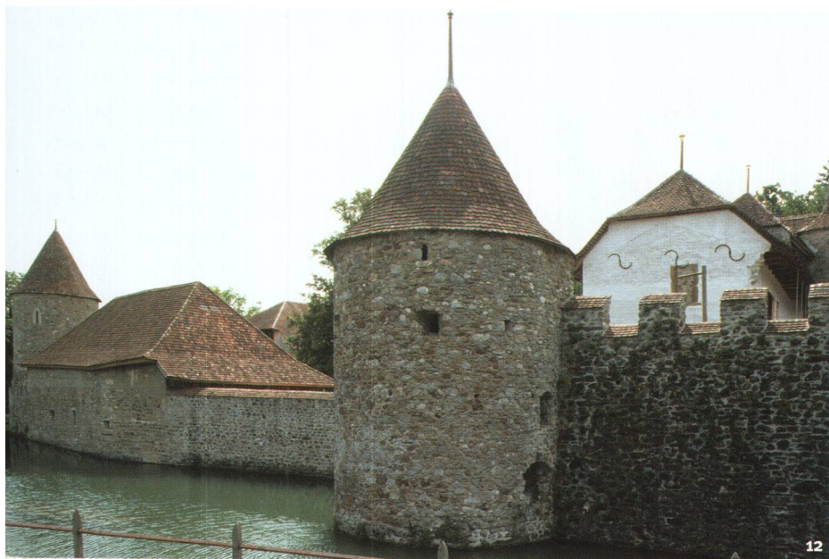
Fig. 12 Le château de Hallwyl. Tour d'artillerie septentrionale rattachée au château central et édiflée vers 1500.
