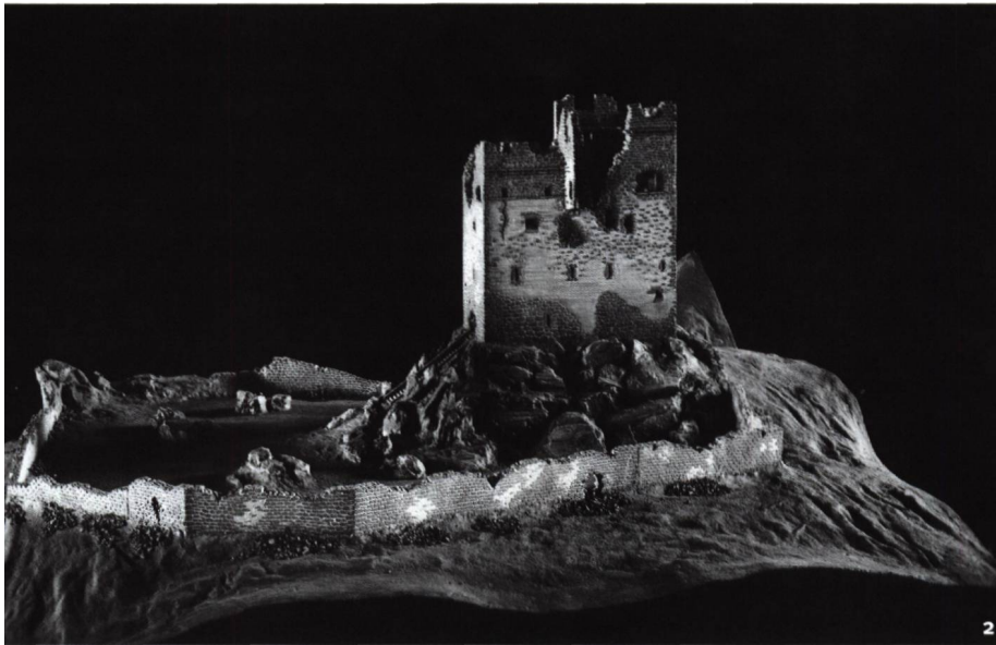
Fig. 2 Ruines du château fort de Wartau (SG). Cette maquette réalisée par A. Schöll en 1872, exposée au Musée historique de Saint-Gall, illustre les débuts des travaux de recherche et de conservation des châteaux forts de la vallée alpine du Rhin.
