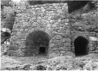
Der 2005 im Melchtal entdeckte Hochofen scheint gleich konstruiert zu sein wie der von 1979-1984 bei Salouf (GR) sanierte Floss- bzw. Hochofen aus dem Jahr 1828.
