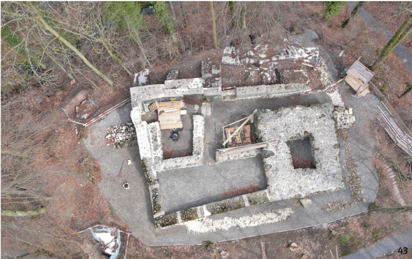
Fig. 43 Vue aérienne du château-fort de Hünenberg juste avant l'achèvement de la restauration en 2009. Les vestiges de la première enceinte, qui longeait le versant, sont à peine visibles. Les éléments bâtis datent pour la plupart du 13 e siècle, avec des restaurations dans les années 1940 et 1960.
