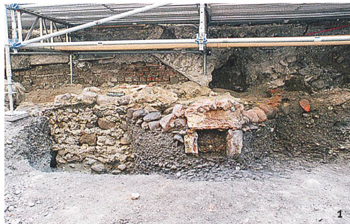
Abb. 1 Baden, Bäderstrasse (AG). Die gegen die Baugrube gemauerten Fundamente des spätmittelalterlichen Gasthauses zum Krebs durchschlagen einen älteren Kalkbrennofen (gerötetes Gestein). Foto: Kantonsarchäologie Aargau.
