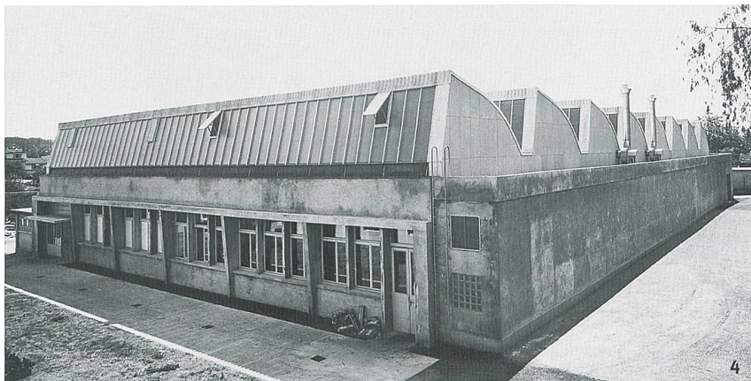
Fig. 4 Construit entre 1958 et le milieu des années 1960 sur des plans de l'architecte Horace Decoppet, le bâtiment qui abrite le dépôt est remarquable par son jeu d'éléments en saillie et de formes carrées.
