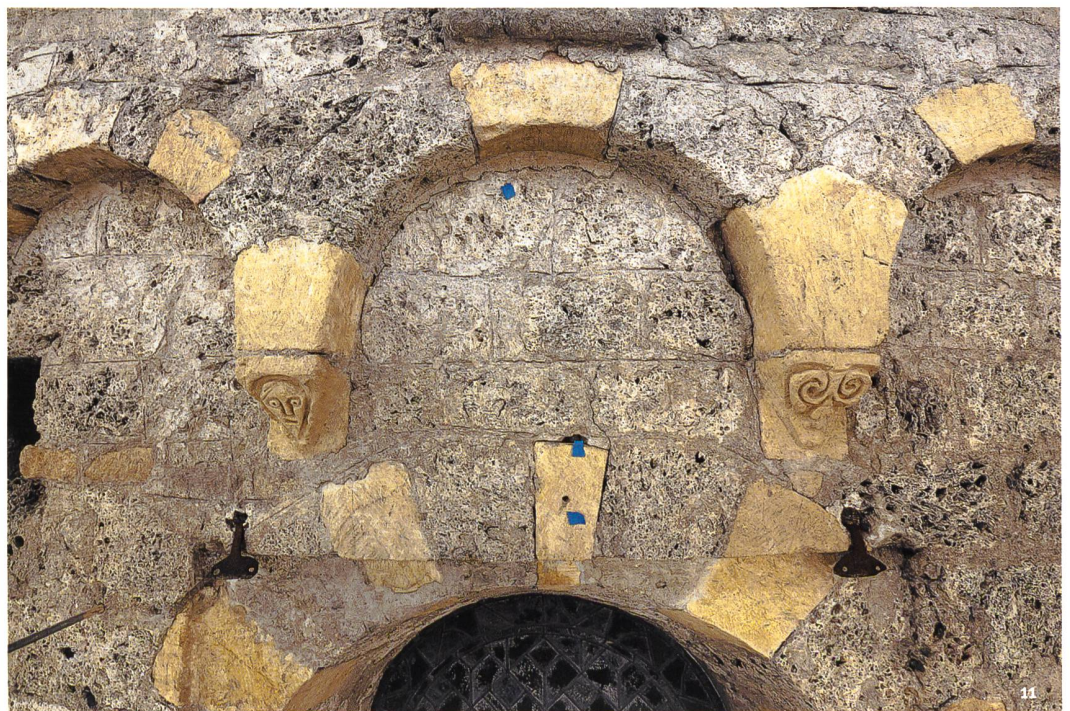
Fig. 11 Chevet de l'église romane. Exemple de polychromie naturelle d'une arcature aveugle surmontant le couvrement d'une baie.
