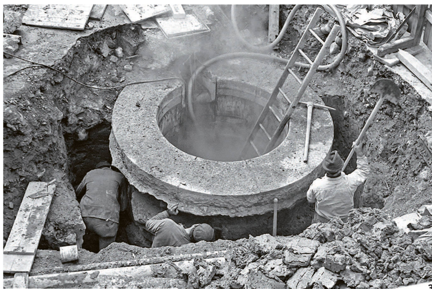
Abb. 3 Ausschachtungsarbeiten an der Quellfassung des «Grossen Heissen Steins» im Jahr 1967.
