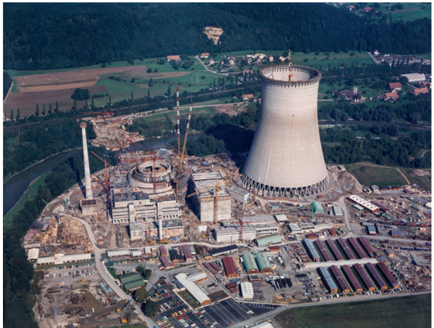
4 Ruinen einer nahen Zukunft? Bau des Atomkraftwerkes Gösgen-Dänikon, 1975.
