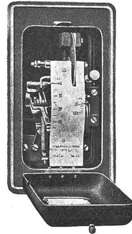
Fig. 9. Maximalstrom-Zeitrelais mit Zeitcharakteristik nach Fig. 8. Bauart: Siemens-Schuckert.
