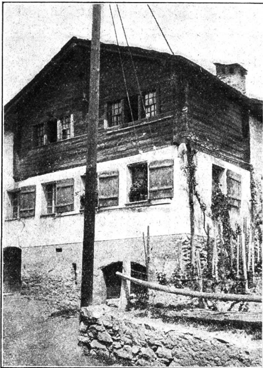
Abb. 7. Der Lichtmast steht zu nahe am Bauernhause.
