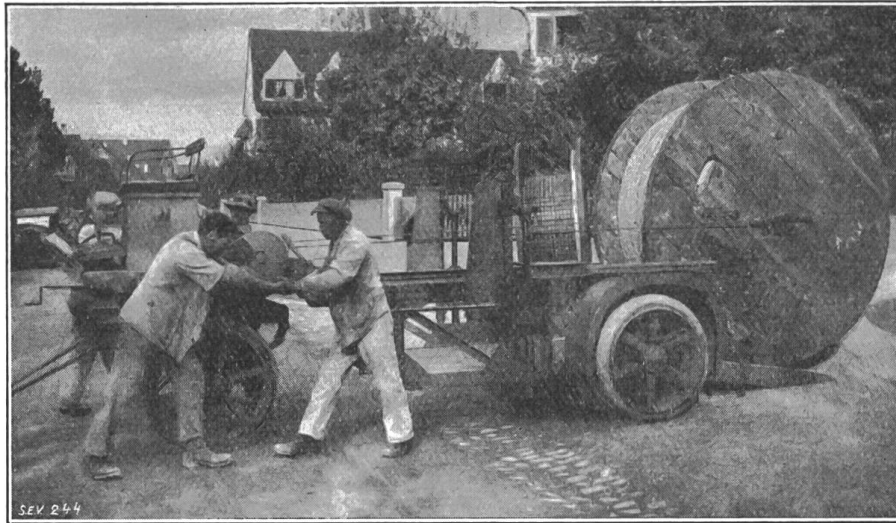
Fig. 12. Kabeltransport- und Verlegungswagen des EWZ beim Beladen auf der Baustelle. (Wytikonerstrasse, 14. Oktober 1926).
