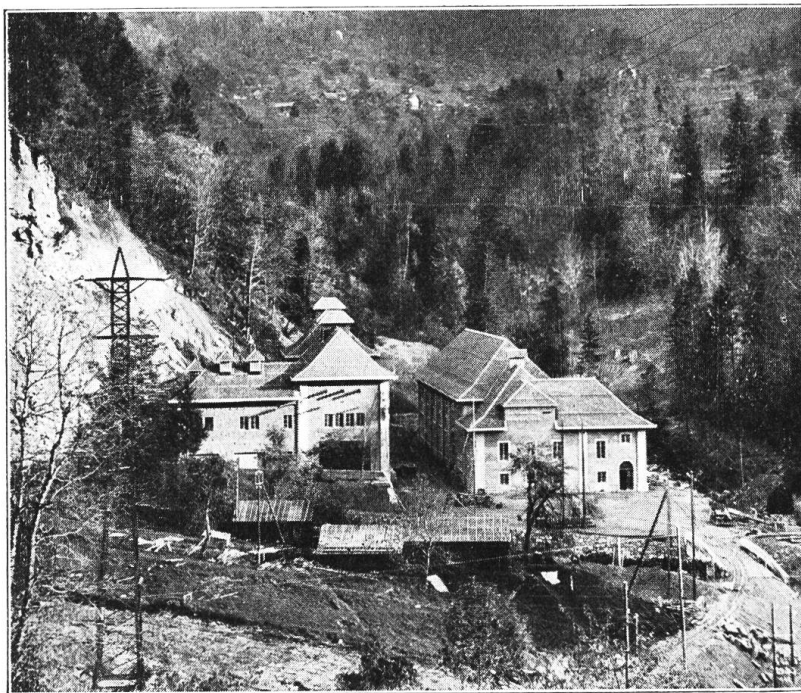
Fig. 14. Usine génératrice et poste de transformation de la Peuffeyre. Vue ouest.
