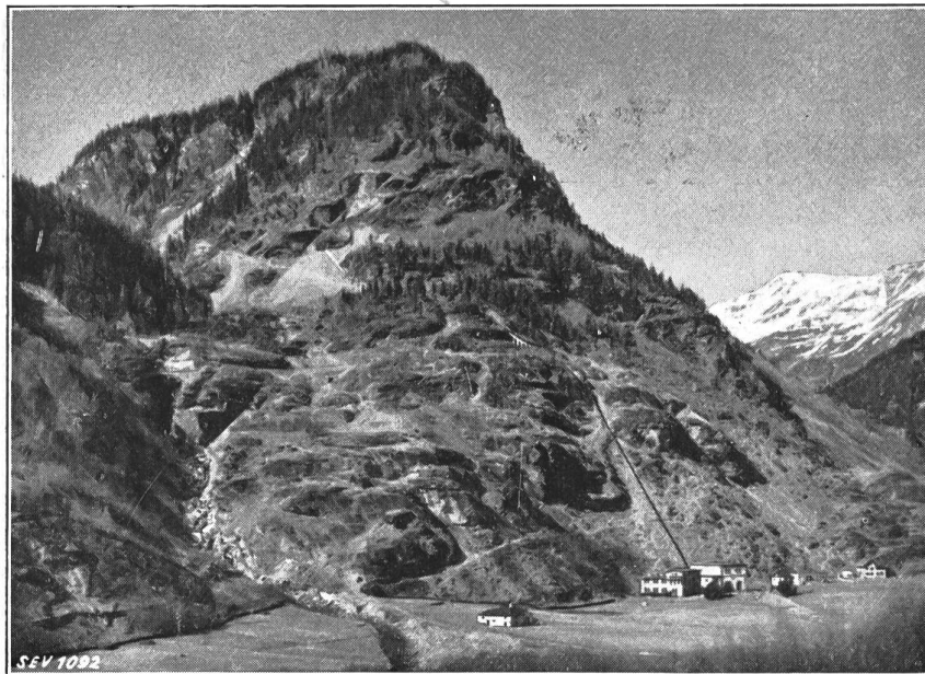
Fig. 4. Kraftwerk Robbia. Gesamtansicht.
