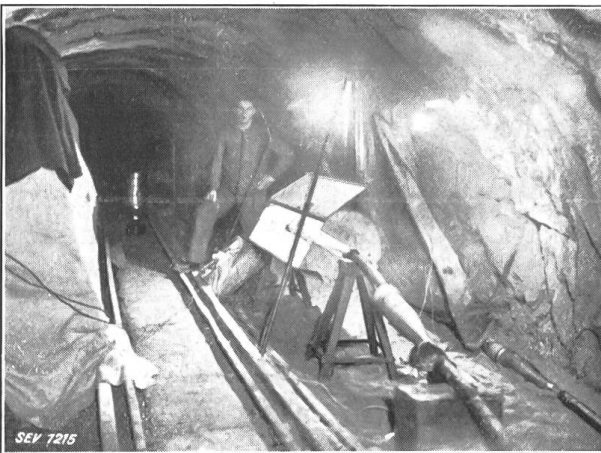
Fig. 21. Herstellung der Verbindungsmuffen.
