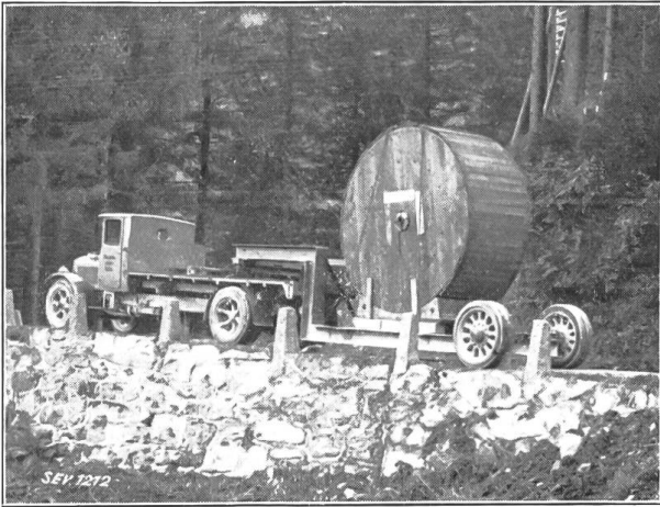
Fig. 19. Transport der Kabel auf der Grimselstrasse.
