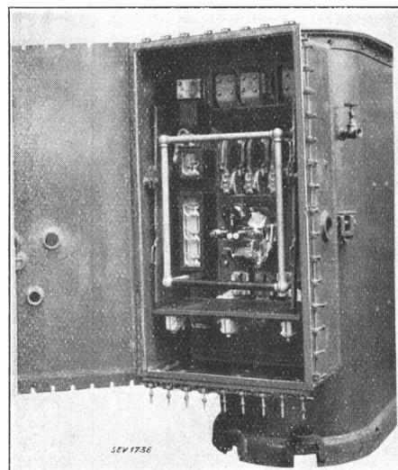
Fig. 11. Netzschalter des Transformators Fig. 10, geöffnet.
