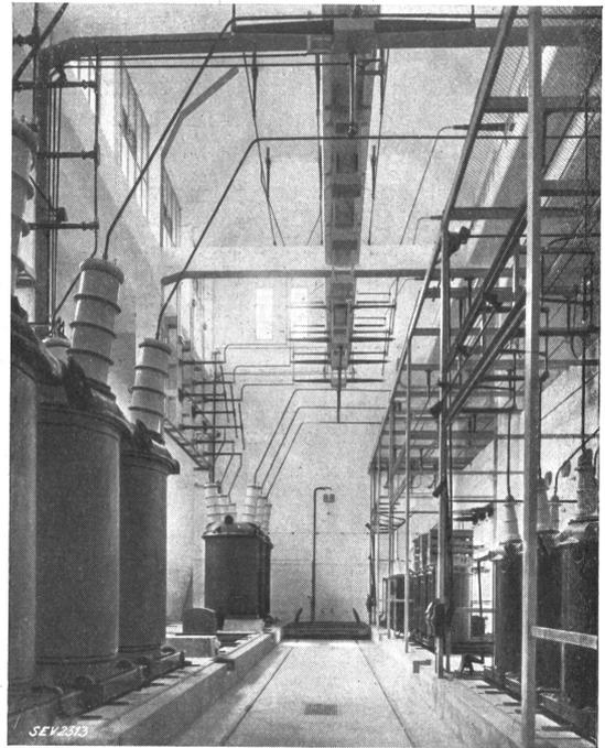
Fig. 24. Schaltanlage Siebnen, 50/150-kV-Anlage (EWZ).
