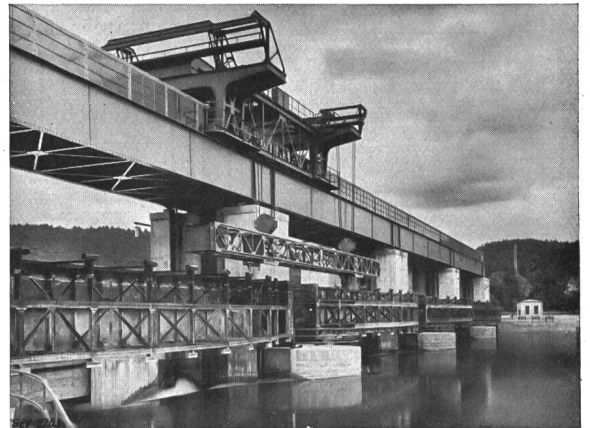
Fig. 6. Le barrage vu de l'amont, avec les panneaux de secours et le pont roulant pour leur manœuvre.
