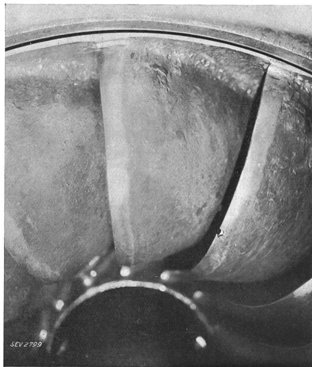
Fig. 15. Nouvel aubage de la roue (fig. 14) après un an de service.
