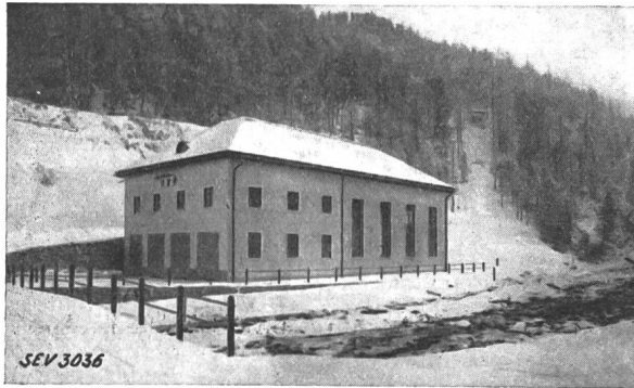
Fig. 1. Maschinenhaus des Kraftwerkes Isas.
