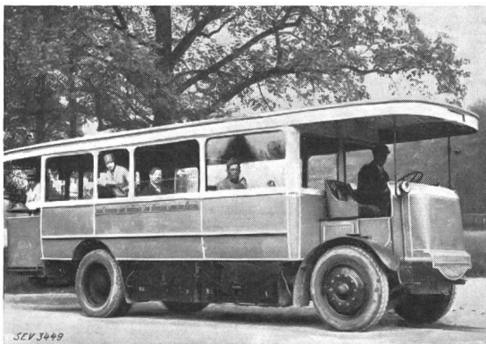
Fig. 1. Electrobus type Renault / Sté Alsacienne. Modèle 1926.
