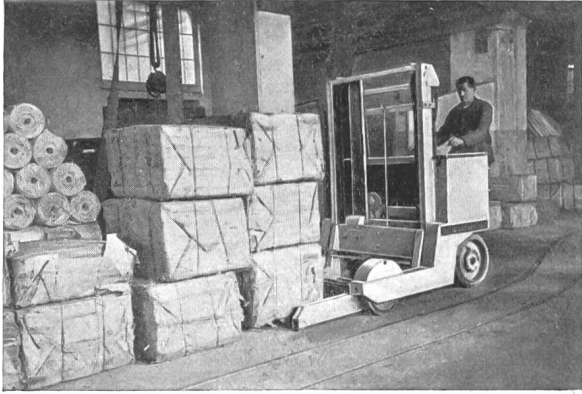
Fig. 15. Elektrostapler beim Abladen von Papierballen.
