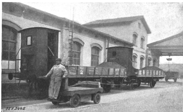
Fig. 6. Elektrokarren beim Ziehen von Eisenbahnwagen.
