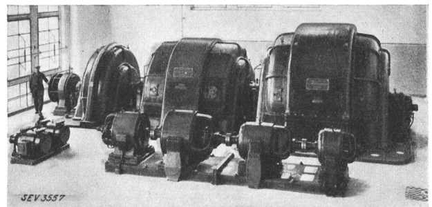
Fig. 24. Frequenzumformer Mühleberg.
