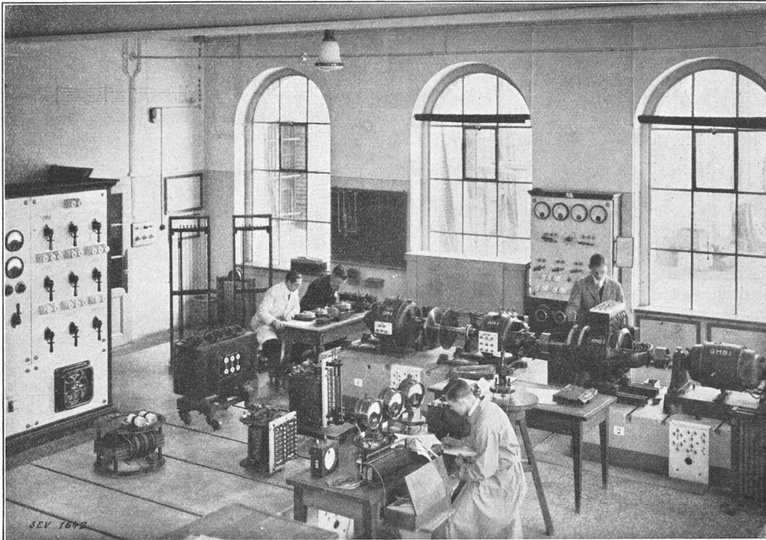
Fig. 2. Gleicher Maschinensaal wie Fig. 1 ab 1917.
