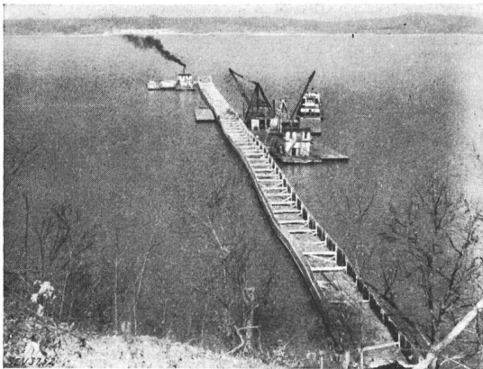
Fig. 3. Baubeginn am Joe Wheeler-Damm. Der Tennessee ist hier über 1800 m breit. Auf dem gegenüberliegenden Flussufer erkennt man die Schifffahrtsschleusen im Bau. Stand der Arbeiten am 11. Dezember 1933.
