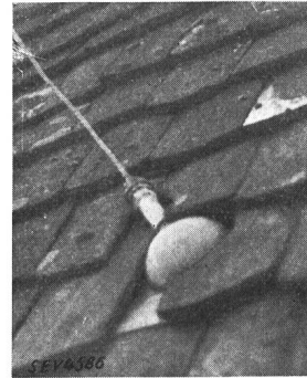
Fig. 3. Dachankereinbindung auf Ziegeldach.
