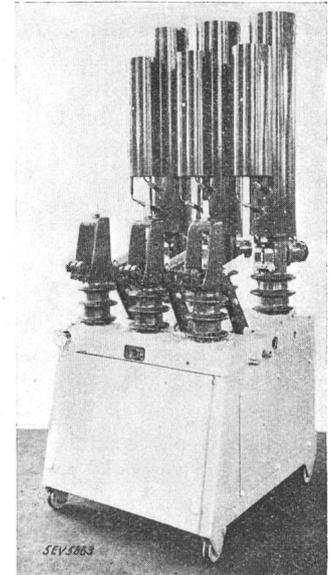
Zeit nach Möglichkeit zu reduzieren, wurde der Druck reduziert und dafür die von der Vielfachunterbrechung bei Oelschaltern her bekannte Stufenschaltung angewendet. Die Unterbrechung erfolgt also in zwei oder mehr Stufen. Zuerst werden
