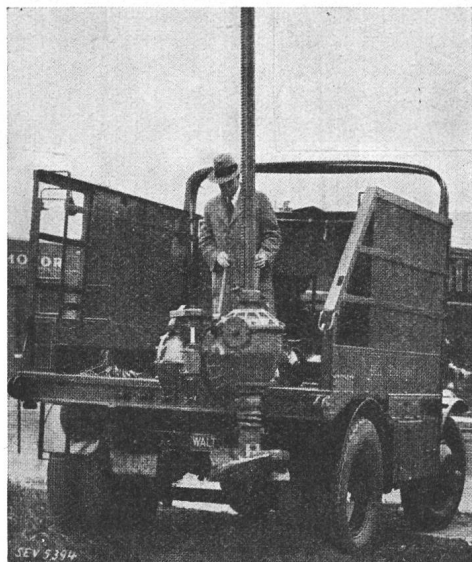
Fig. 39. Automobil mit Mastlochbohrer. (Der Bohrer kann gekippt werden.)
