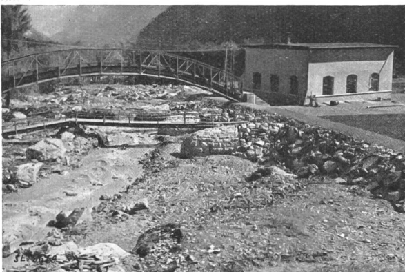
Fig. 14. Das wiederhergestellte, schmucke Werk Stechelberg.
