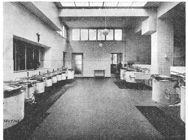
Fig. 4. Cuisine électrique d'hôpital à Lucerne. Aménagée selon les principes les plus modernes.
