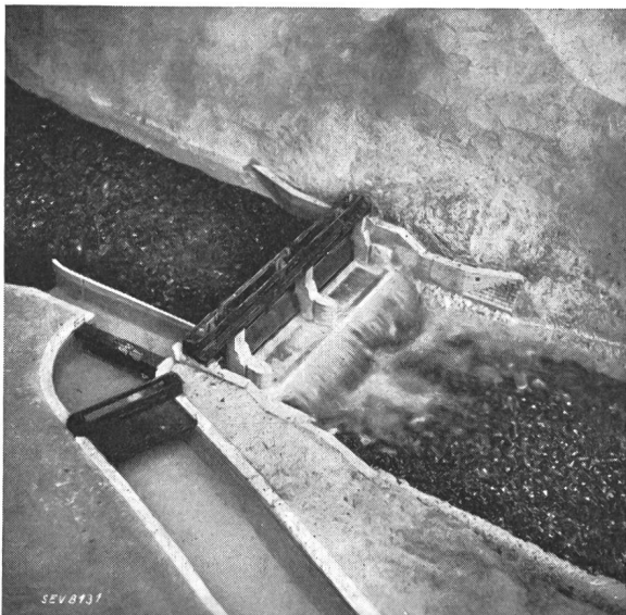
Fig. 5. Wasserfassung zum Mitteldruckwerk.
