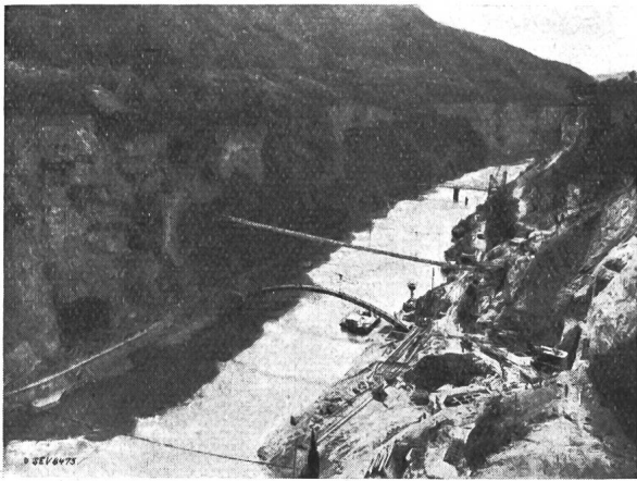
Fig. 4. Usine de Génissiat. Vue générale du chantier de l'amont.
