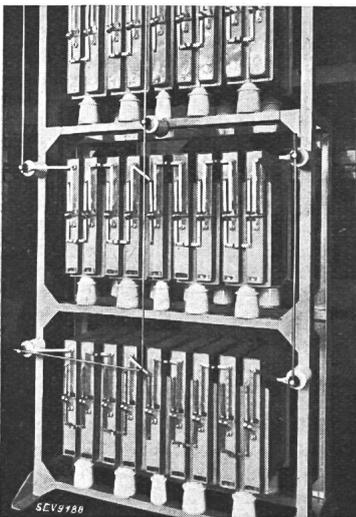
Oben: Hochspannungs-«Nepolin»-Kondensatoren-batterie von 500 kVar, 6000 V, 50 Hz.
