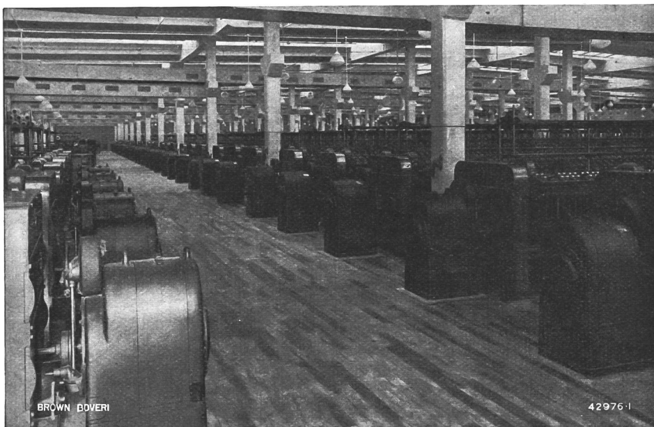
Fig. 7. Ringspinnmaschinen mit Nebenschluss-Kommutatormotoren und Spinnreglern.
